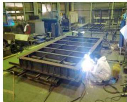
▲ 周辺機器等の製缶作業
