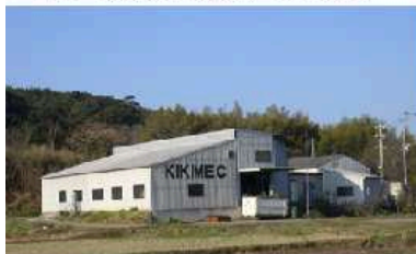
▲マシンセンター(敷地1,000㎡,工場600㎡)
