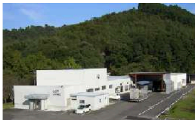
▲本社工場(敷地19,000㎡,工場1,800㎡)
