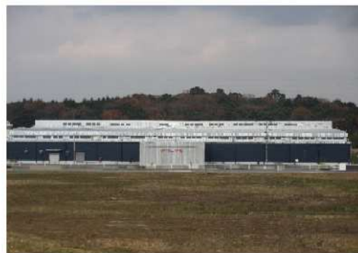
▲山宗(株)大分工場 2期工事完了 2016年12月
