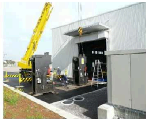
3. 工場工事・メンテナンス・FAエンジニアリング
